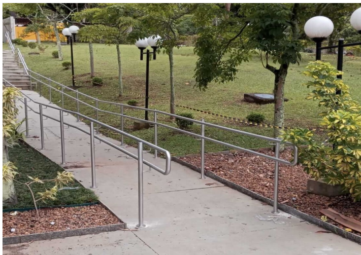
FIGURA 14 : CORRIMÃO DUPLO FIXADO NO PISO ( MODELO 4 )
